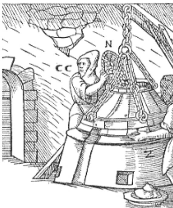
**Obr. 2.** Šachtová pec podle Agricoly.
