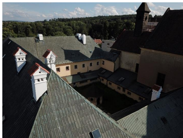
Obrázek 21 Nově opravené komíny
